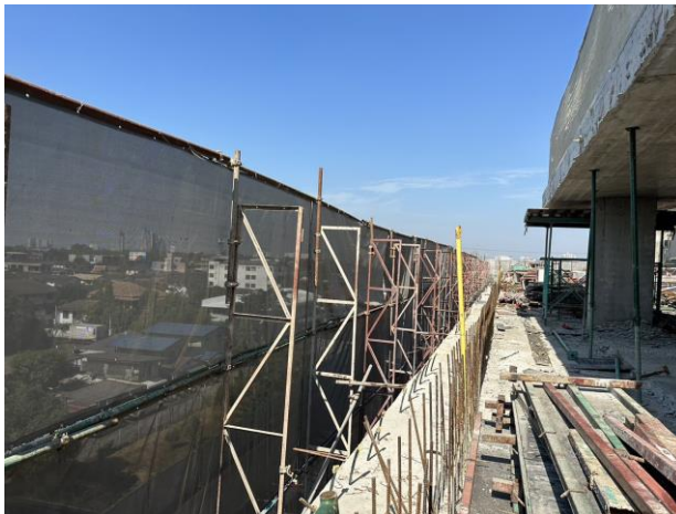
รูปที่ 9 mesh sheet บนอาคารแต่ละชั้น
